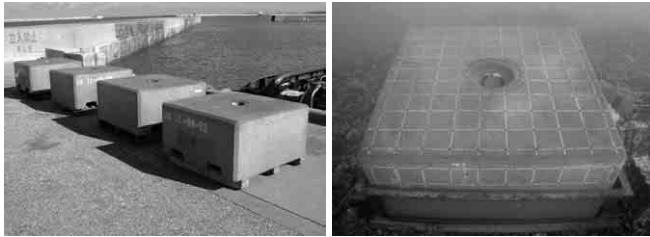
写真7 マリブロック (サンゴ礁造成基盤) Photo 7 Marine Blocks (Artificial base for coral reefs)
